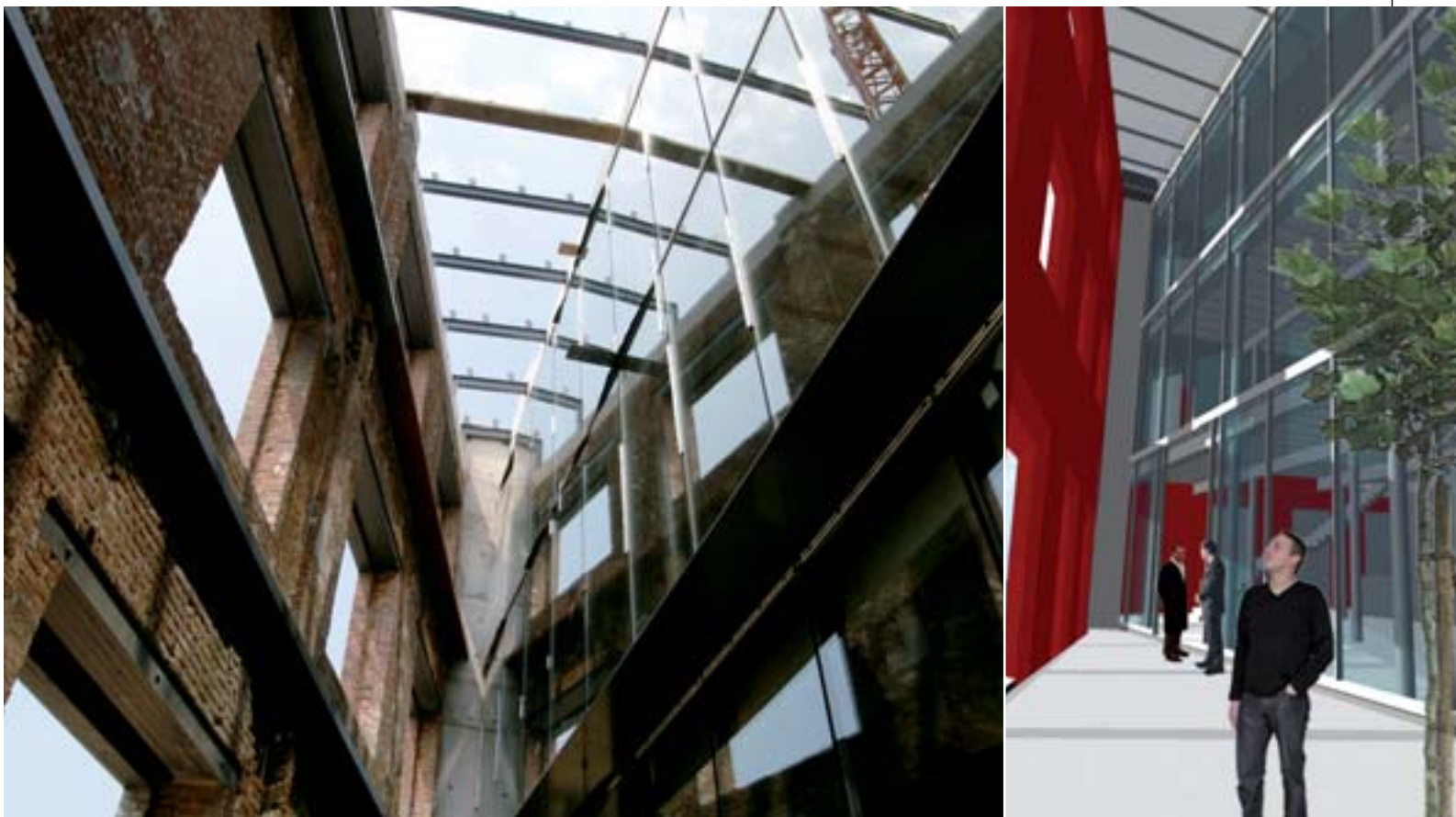
De stenen gevel is de oorspronkelijke. Daarachter kwam er een nieuwe, glazen gevel (Foto: M.S. – Tekening: Architectenkoopratief/JJS bvba - Bogaerts Architectuur en Interieur)
