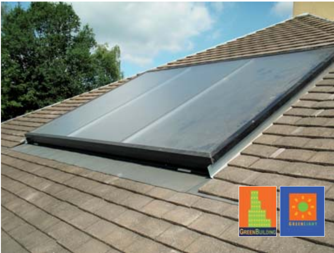
Natuurpunt installeerde een zonneboiler voor warm water (Foto's: Izen nv)
